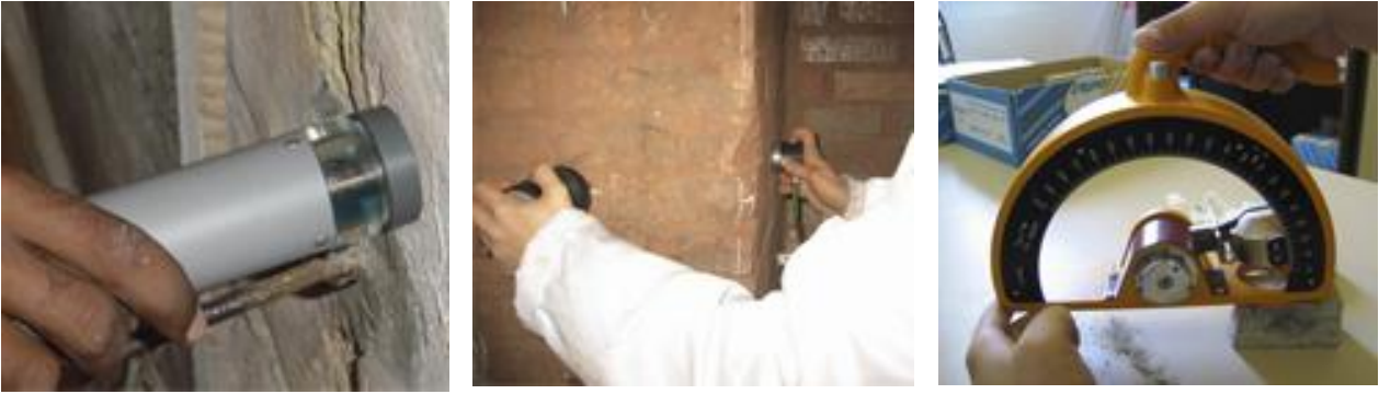
Figuras 4.1: Ensayos no destructivos (END): Determinación de potenciales de corrosión en las barras de acero de estructuras de hormigón armado (izda.). Métodos sónicos y ultrasónicos para estimar las propiedades mecánicas de elementos estructurales (centro). Esclerómetro de morteros para estimar su resistencia (dcha.)
