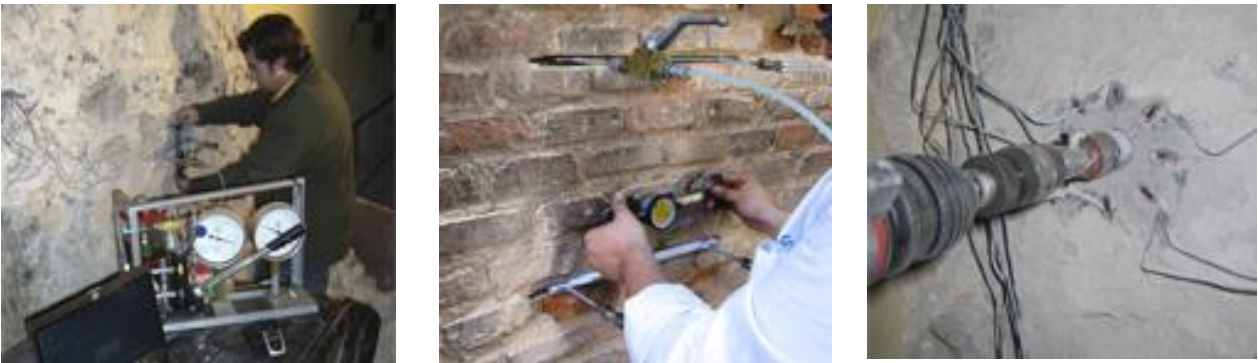
Figuras 4.2: Ensayos ligeramente destructivos: El “Gato plano Simple” permite obtener el nivel tensional local en un elemento estructural (izda.). El “Gato plano Doble” permite obtener las propiedades mecánicas y de deformabilidad de una porción de una estructura de fábrica (centro). El “Hole drilling” permite obtener, también, el nivel tensional local de un elemento estructura (Dcha.).
