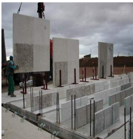
Figuras 3.10: Tesis Doctoral del Dr. Juan Figueroa (2005): Estudio experimental de las condiciones de durabilidad de diferentes tratamientos superficiales aplicados a elementos prefabricados de hormigón expuestos a distintos ambientes en España y Chile.
